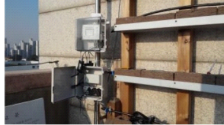
b. 모니터링 센서 설치
