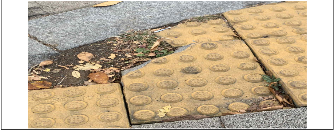
[그림 5-16] 훼손된 점자블록
