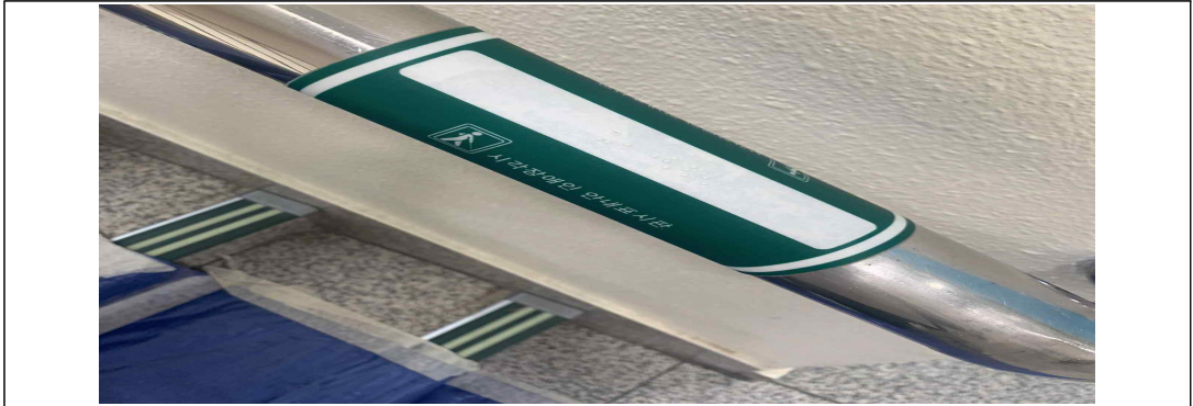
[그림 5-21] 계단 손잡이의 시각장애인 안내 점자 및 미끄럼 방지 패드
