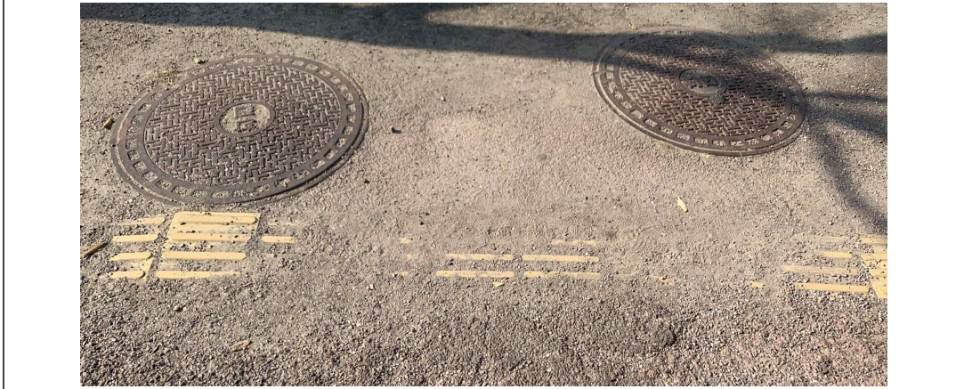
[그림 5-34] 관리가 되지 않은 점자블록
