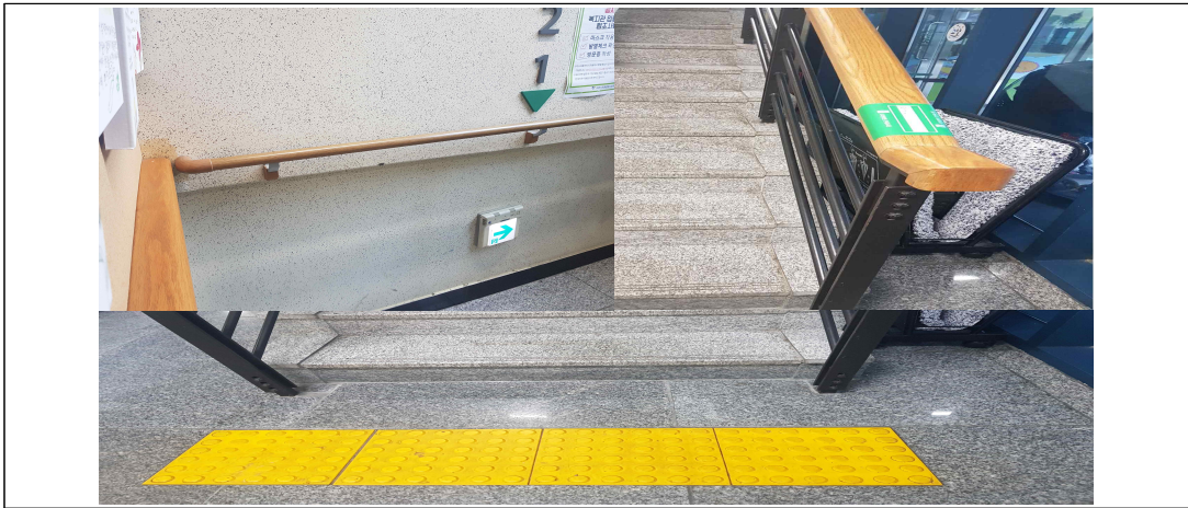
[그림 5-38] 계단 안내 점자 및 끊어지지 않는 난간
